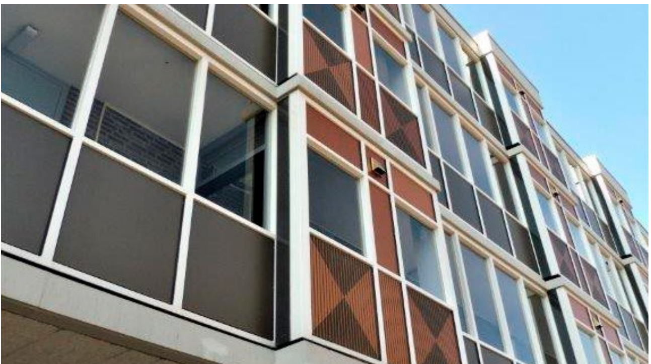
Buitenzijde woongebouw Prinsenhof na het groot onderhoud
