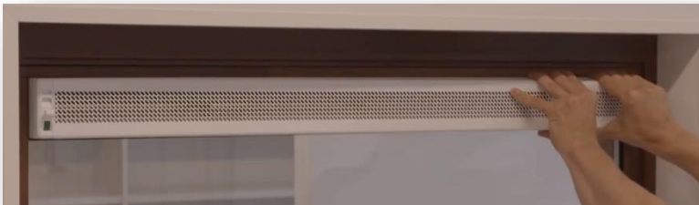
Roosterkap los klikken vanuit de binnenkant
